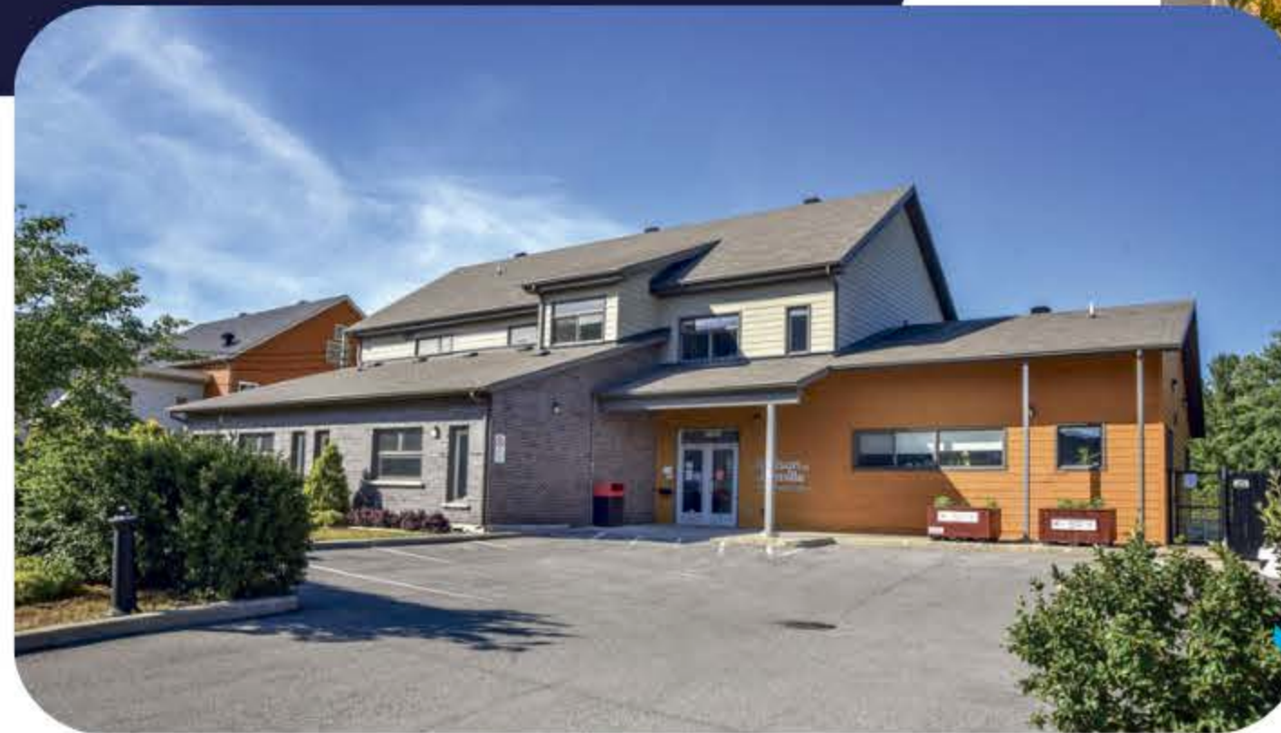
Installation principale de la MFM
